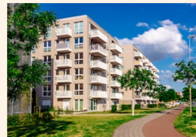
Affordable housing on Marcuskaje, Überseestadt
